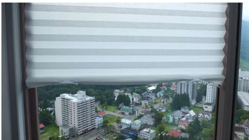
断熱効果は期待できませんが、夏季であれば赤外線反射により室内の温度上昇が抑えられます。直射日光を遮るのでカーペットの焼けを防ぐ効果があります。
