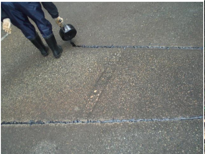
ひび割れ部補修
