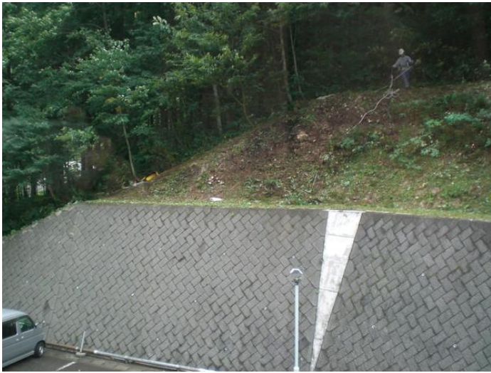
施工部伐採①
