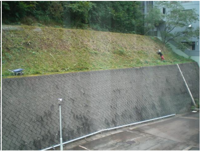
施工部伐採②
